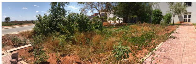
Figura 3 – Situação externa da ETE inicialmente.
