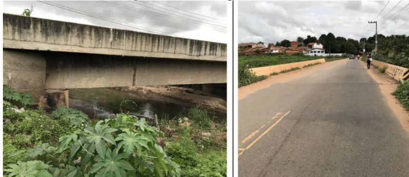
Figura 19 – Fotografias da Ponte 02
