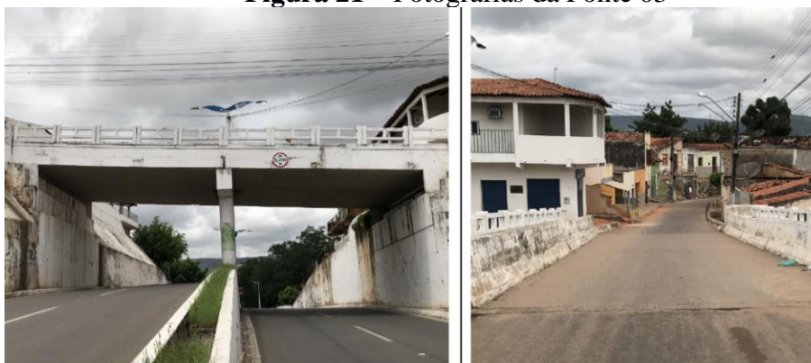
Figura 21 – Fotografias da Ponte 03
