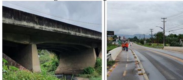
Figura 10 – Fotografias da Ponte 01
